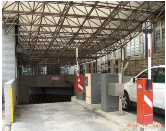
新化鎮廣停二地下停車場車道出入口 （圖片來源：102 年 1 月 8 日現場拍攝）
