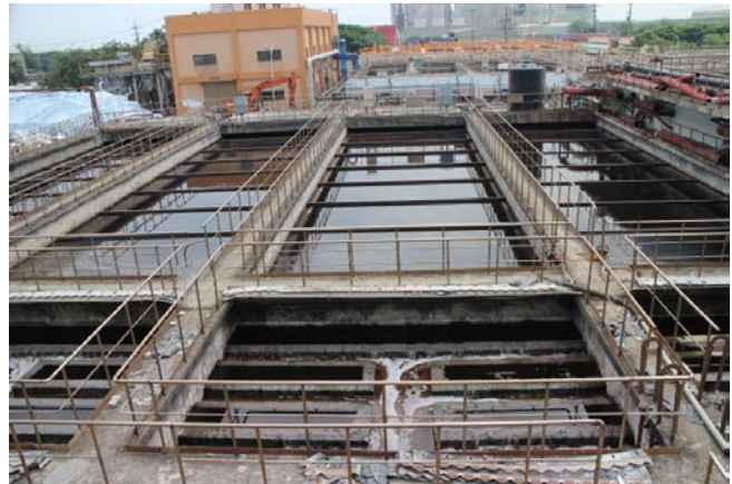
大園工業區污水處理廠 （經濟部工業局提供）
