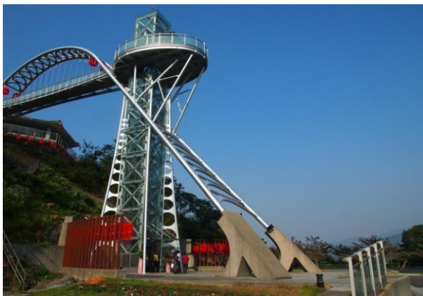
電梯塔及觀景餐廳等設施啟用情形 （水利署提供）
