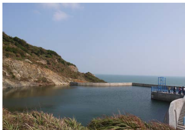
西莒樂道沃水庫改善工程完工蓄水情形 (102 年 10 月拍攝)
