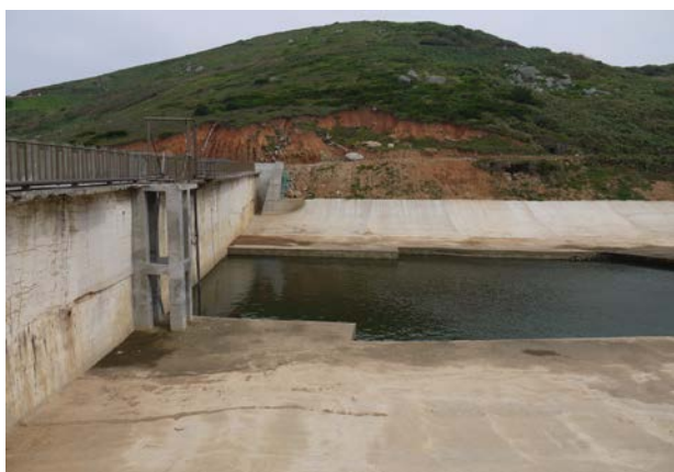
東引紫沃水庫改善工程完工蓄水情形 (102 年 9 月拍攝)
