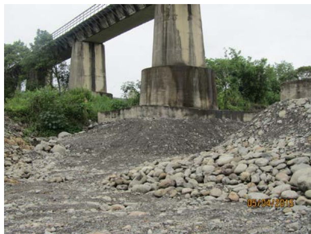
竹東大橋橋基裸露改善情形 (臺鐵局提供)
