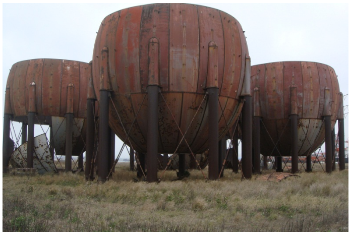
臺中港西 6 碼頭後線儲槽實況 (台中港務分公司提供)
