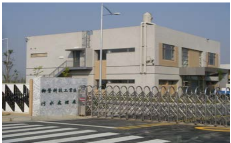
柳營科技工業區污水處理廠 (臺南市政府經濟發展局提供)
