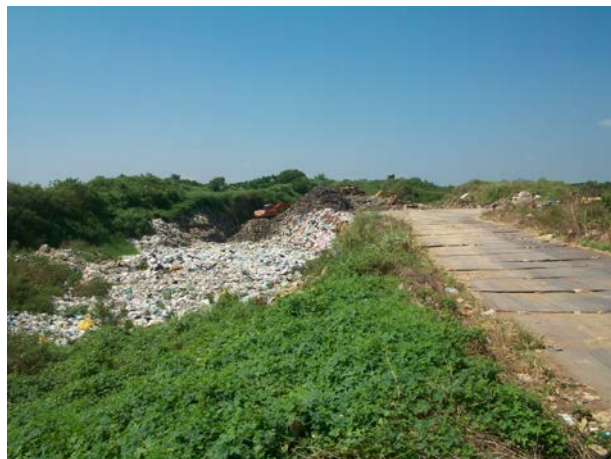
桃園縣八德市大安垃圾掩埋場 (桃園縣八德市公所提供)
