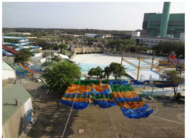
臺南市城西垃圾焚化廠回饋設施 (臺南市審計處 102 年 4 月 23 日拍攝)
