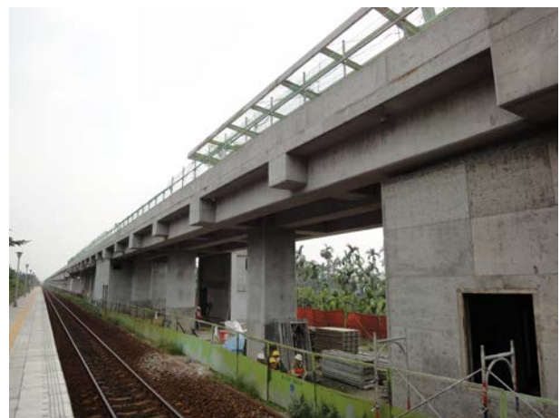
本案工程部分現場施工情形 (100 年 9 月 22 日拍攝)
