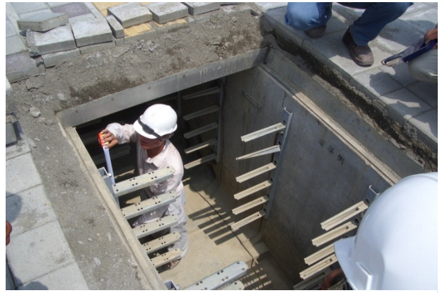
高鐵路車站特定區預埋管道建置情形 （交通部高速鐵路工程局提供）
