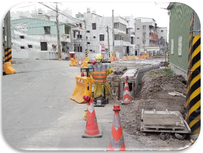
嘉義市許厝庄 12 米計畫道路工程施工情形 (110 年 1 月 8 日拍攝)
