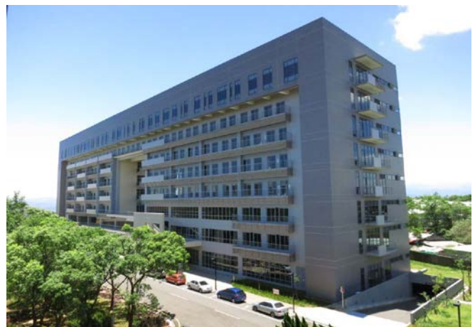
臺師大林口校區資訊與教學大樓完工照片 (擷自臺師大青年報網站)
