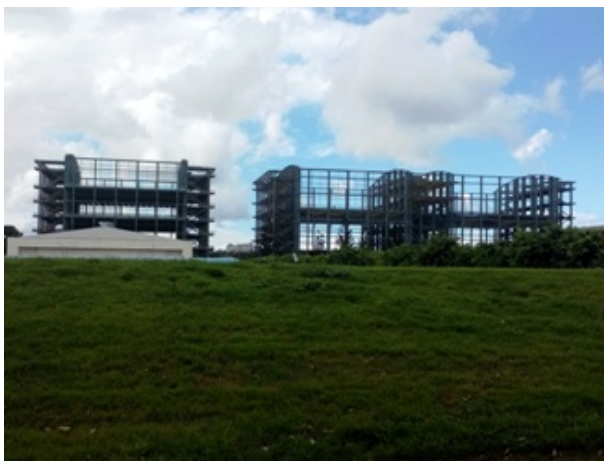
審計部查核時國訓中心施工情形
