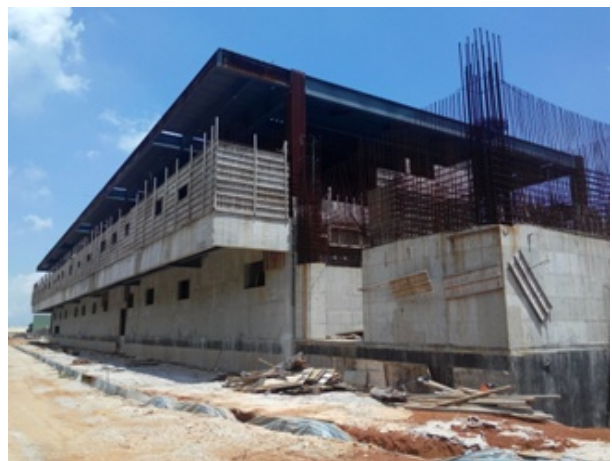
審計部查核時公西靶場施工情形
