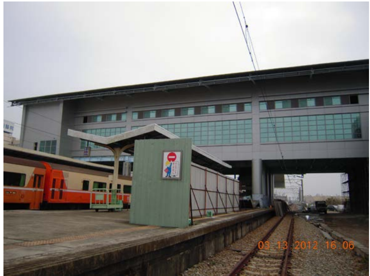
沙鹿站跨站式站房新建工程
