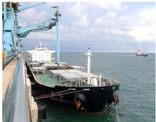
興達電廠卸煤碼頭卸煤情形 （台電公司提供）
