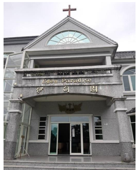
違法設置之伊甸園納骨堂 (花蓮縣秀林鄉公所提供)
