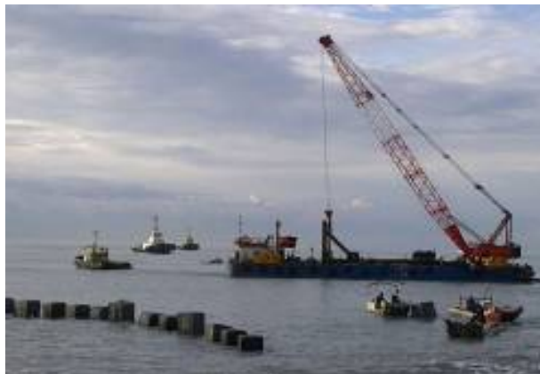
深層海水取水管施工佈設情形 （水利署提供）
