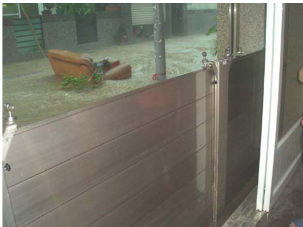
住家設置防水閘門 (內政部營建署提供)
