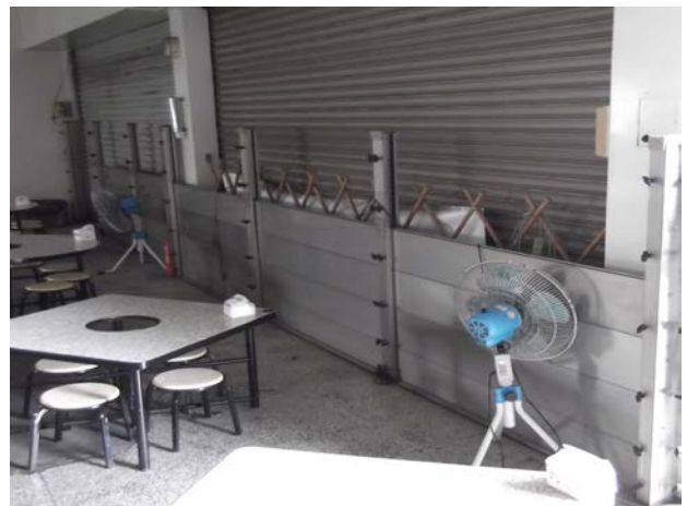
餐館設置防水閘門 (102 年 1 月 21 日拍攝)
