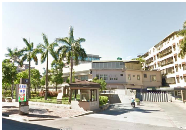
新北市板橋區正隆公園地下停車場 (新北市板橋區公所提供)
