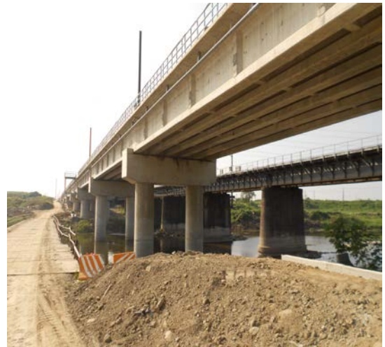
二層行溪橋改建工程 (101 年 12 月 13 日拍攝)
