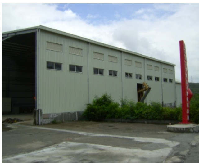
屏東縣恆春鎮裝潢修繕廢棄物分類回收 再利用處理中心
