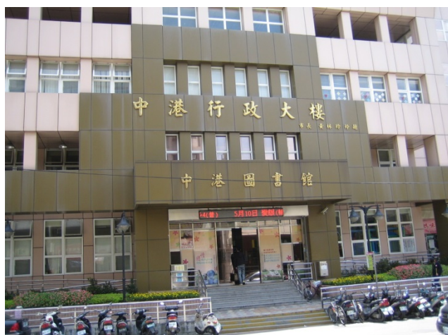
新北市新莊區中港行政大樓 (新北市新莊區公所提供)
