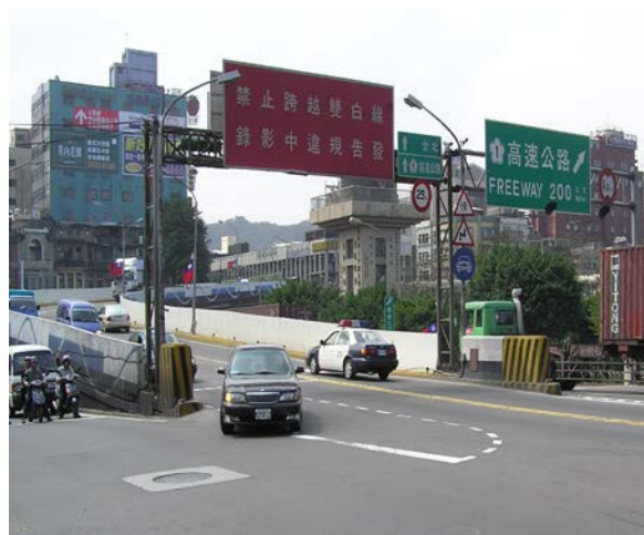
中正高架橋補強工程 (基隆市政府提供)
