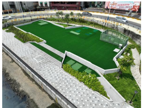
基隆市旭川河淨水廠現況空拍照
