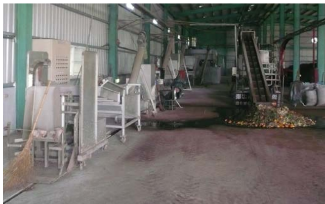
彰化縣田尾鄉堆肥廠熟廚餘處理設施閒置情形 (彰化縣審計室 102 年 9 月拍攝)
