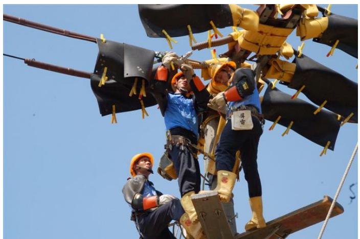
台電公司配電外線工程活線作業 (轉載自台電公司網站)
