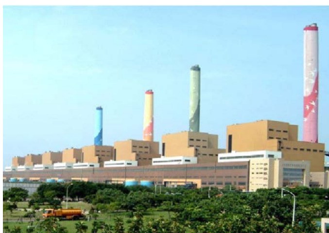
臺中火力發電廠 (台電公司提供)
