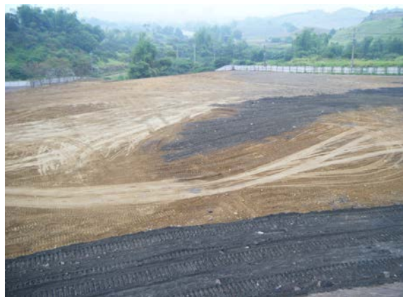
大寮潭平段廢棄物清理完成 (國產署提供)
