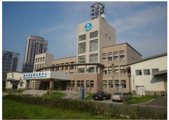
水利署第二河川局區域防洪指揮中心一景 (民國104年4月29日拍攝)
