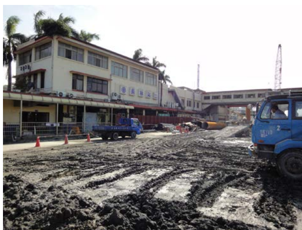
員林市區鐵路高架化工程 (100 年 12 月 8 日拍攝)
