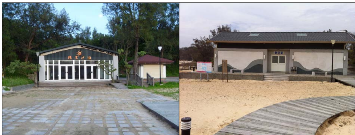
溪邊海水浴場部分設施現況 (102 年 8 月 5 日拍攝)
