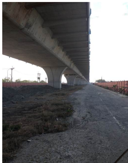
橋下兩側平面車道封路狀況 (102 年 2 月 1 日拍攝)
