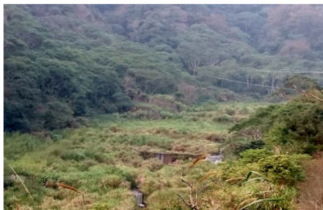
南投縣仁愛鄉東眼山溪防砂壩下游護岸現況 （南投縣仁愛鄉公所提供）
