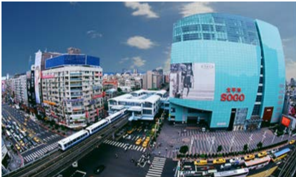
臺北捷運系統木柵線忠孝復興站(BR4)土地聯合開發大樓 (臺北市政府捷運工程局提供)
