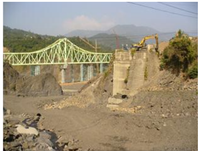
圖 3 「高 133 線莫拉克災修工程第五標 4K+750 紅水仙橋重建工程基樁橋台施作」圖
