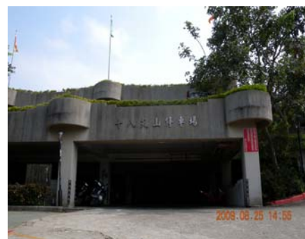
十八尖山立體停車場 完工多年未取得使用執照
