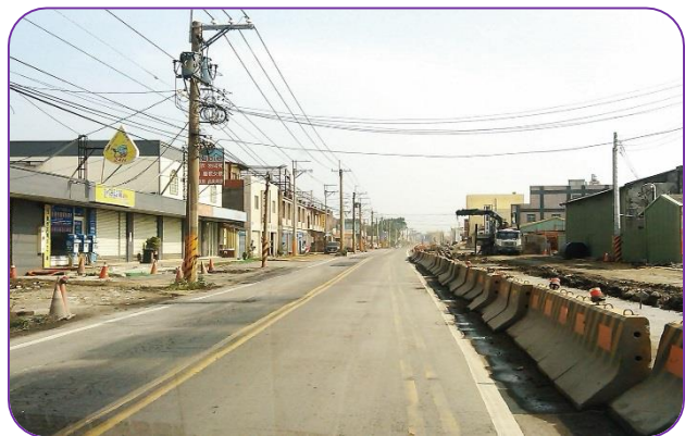
彰化縣縣道148線11K+586~13K+784段道路拓寬工程施工情形
