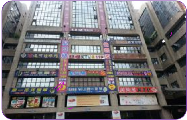
臺中市第一廣場大樓外觀
