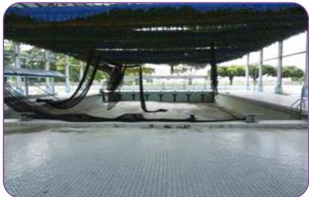
臺南市官田區游泳池主體設施
