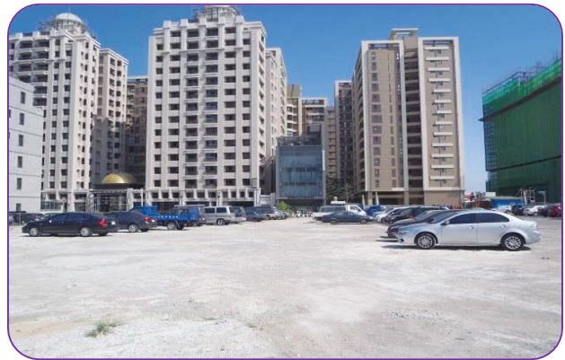
新竹市身心障礙者就業綜合大樓興建計畫用地現況
