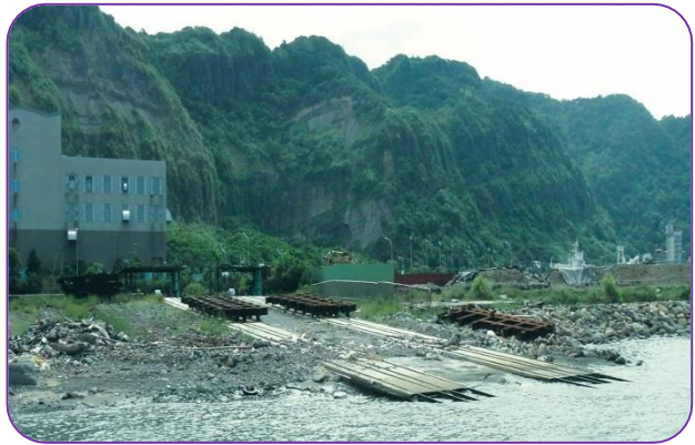
基隆市八斗子漁港曳船道完工現況
