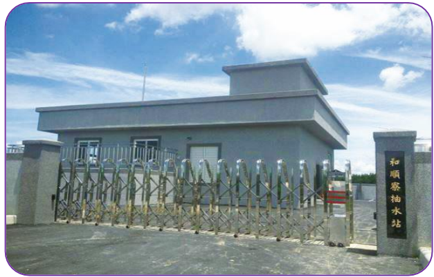
臺南市安南區和順寮抽水站 (圖片來源：臺南市政府水利局提供)
