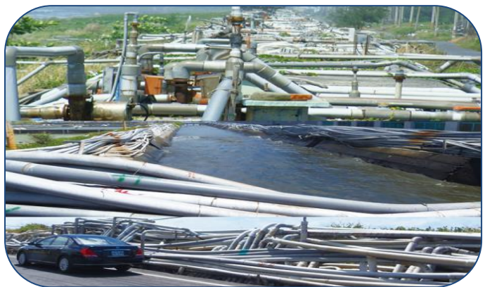
屏東縣佳冬鄉及枋寮鄉沿岸海堤佈滿水管集束及抽水機
