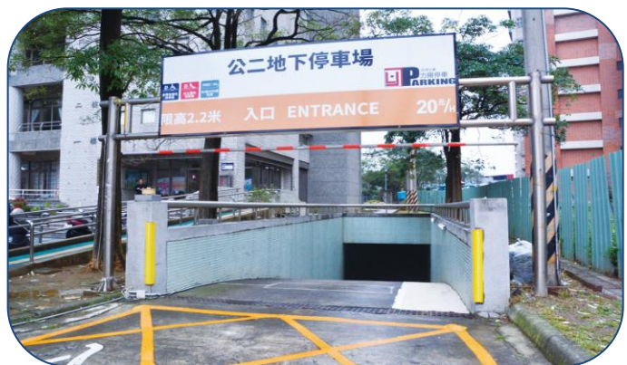
桃園市八德區公二地下停車場出入口
