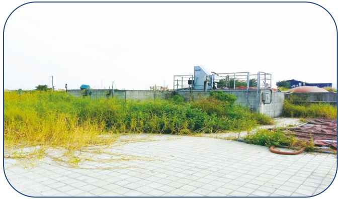
彰化縣綠金加值園區廢水處理場
