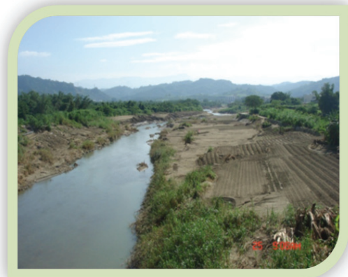
南投縣軍功寮溪新設堤防護岸工程未能防範水患
