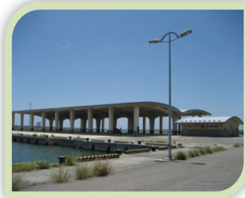
嘉義縣布袋第三漁港擴建工程設施閒置
