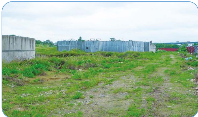
苗栗縣後龍鎮污水下水道系統核心工程終止契約後場址概況
