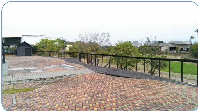
嘉義縣三疊溪橋下生活污水濕地水質改善第 2 期工區閒置情形
