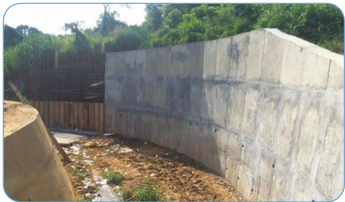
臺中市區外排水設施改善工程護岸完工情形
