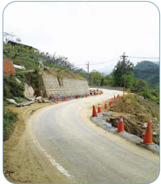
臺中市中 47 線東崎路(三叉路至觀音橋)拓寬工程現場施工情形
