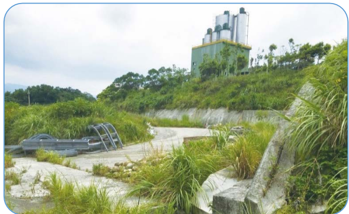
新北市樹林動力計排煙檢測站興建工程計畫 終止後場址概況
