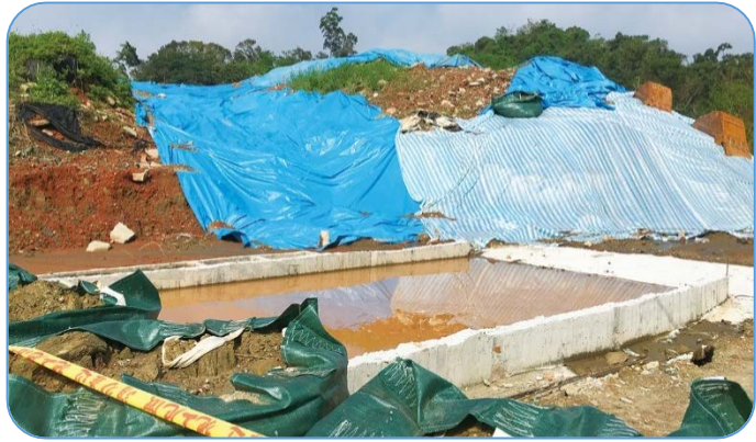
高雄市仁武暫置區土壤污染整治場址
