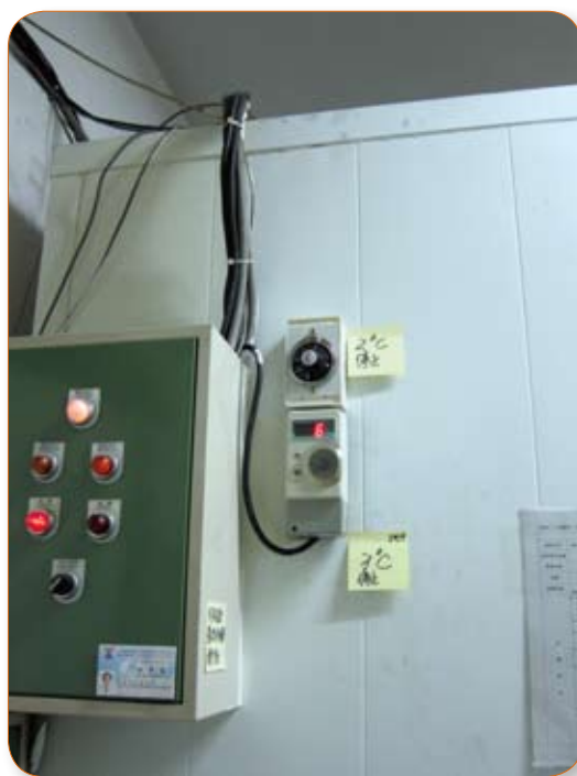
臺中市衛生局疫苗溫度警示系統
