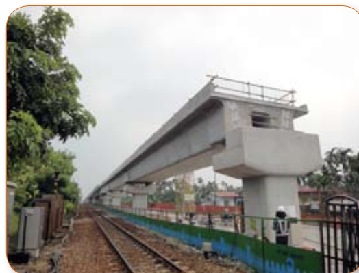
臺鐵高雄—屏東潮州捷運化建設計畫之高架化施工情形
