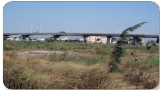
市政中心重劃區抵費地閒置荒廢情形
