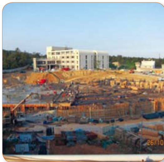
金門綜合醫療大樓興建工程
