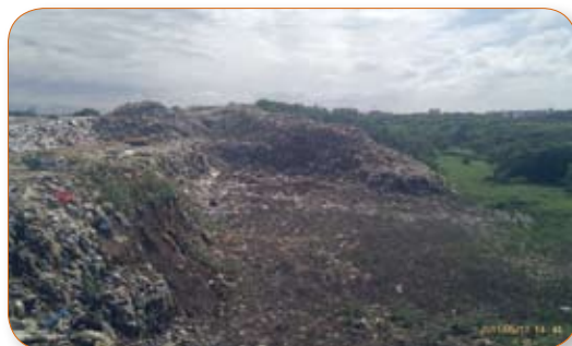
桃園縣八德市大安垃圾掩埋場改善(含復育)工程
