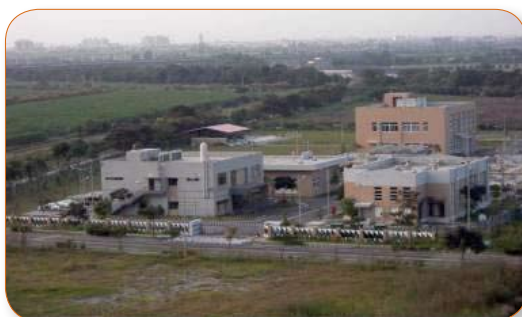
臺南市柳營科技工業區污水處理廠
