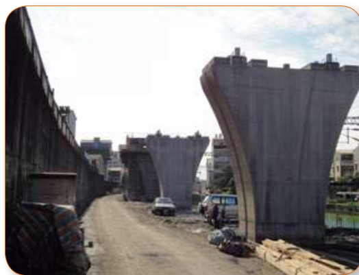
員林高架橋工程之施工情形
