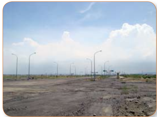
興達港遊艇產業專區開闢之道路
