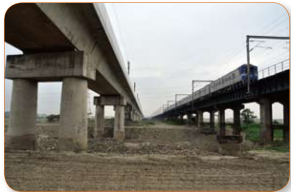
曾文溪橋改建工程—新橋與舊橋
