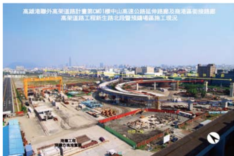
高雄港聯外高架道路計畫施工概況
