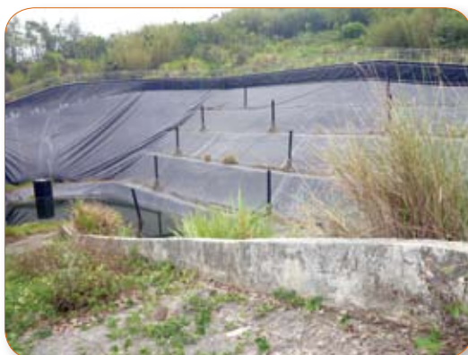
集集鎮區域性垃圾衛生掩埋場閒置情形
