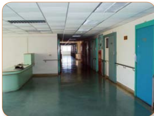
長青公寓5-7樓空間閒置
