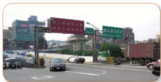
基隆市中正高架橋
