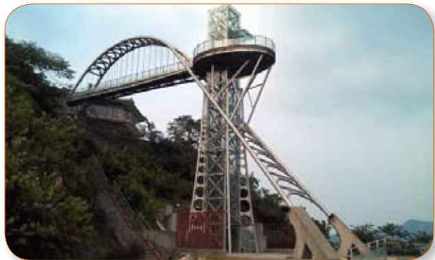
曾文水庫觀景樓電梯塔
