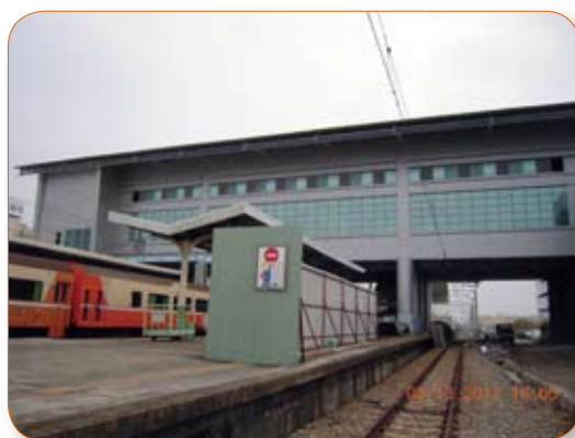
沙鹿站跨站式站房新建工程
